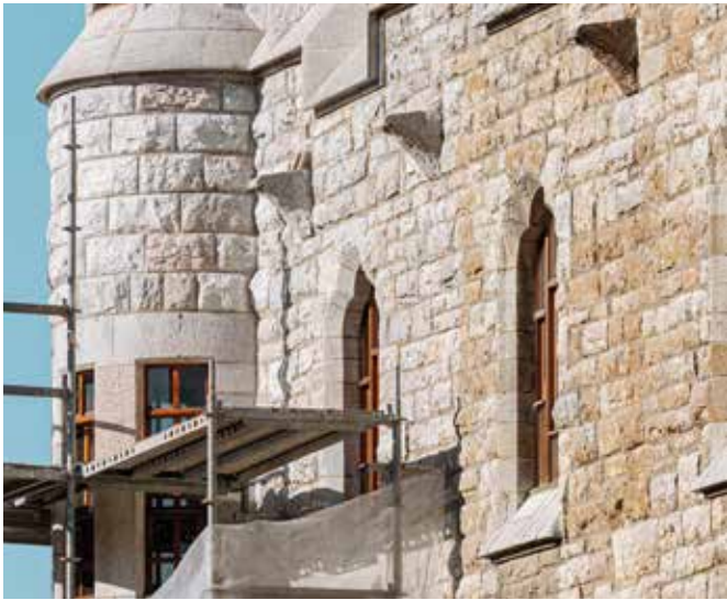
↑ Contraste de limpieza entre una zona limpia y otra aún sin proyectar. Fachada este.
