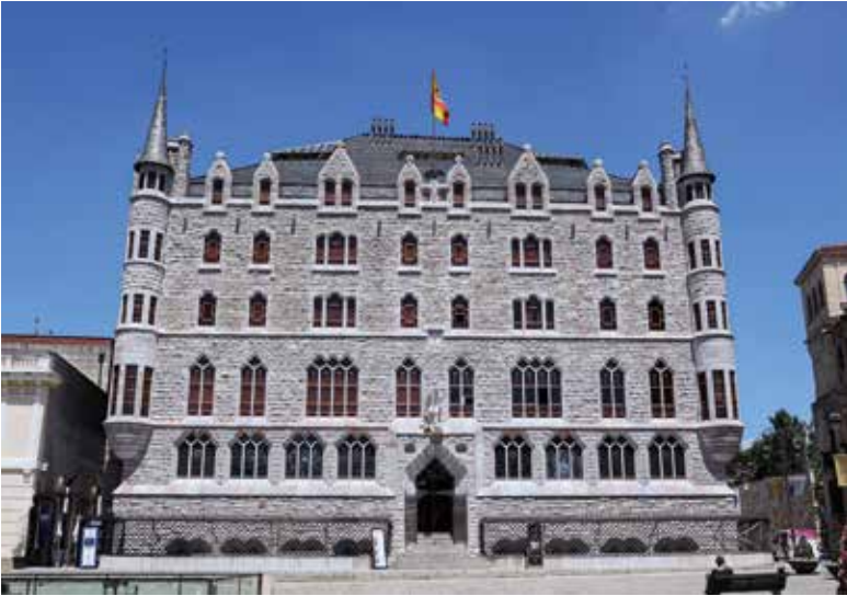
↑ Antes y después de la restauración. Fachada sur o principal.
